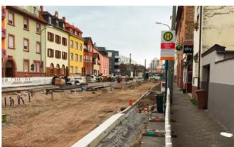
Die Bushaltestelle Friesenheim Mitte nimmt Form an.
