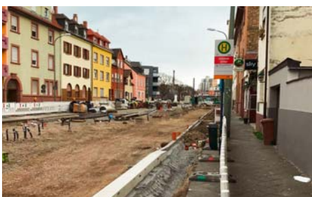
Die Bushaltestelle Friesenheim Mitte nimmt Form an.
